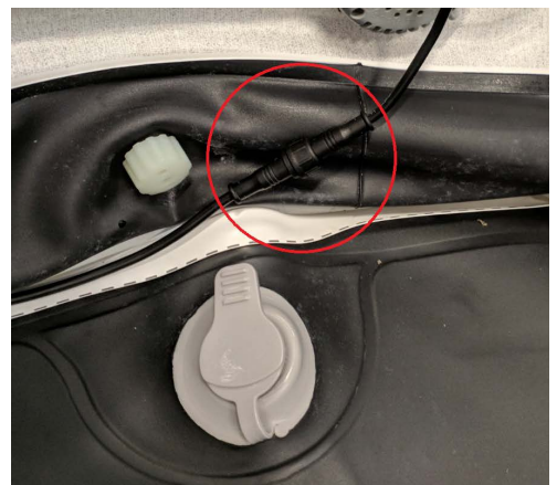
4. Anslut strömkabeln till led-slingan
